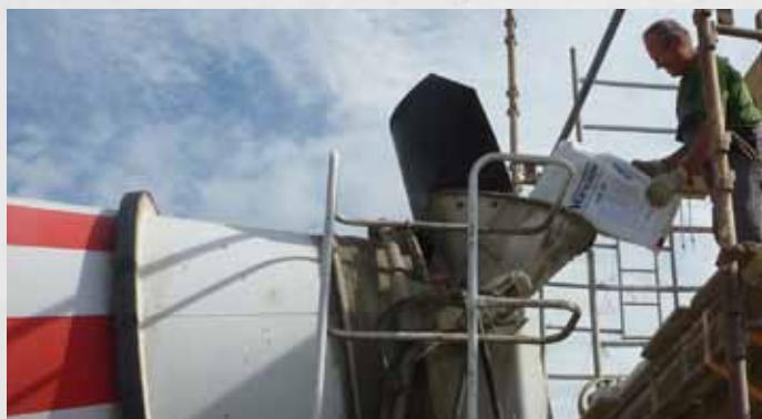
VANDEX AM 10 wird in der Mischanlage zugeführt.
